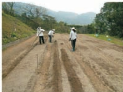
工人們正在挖溝
