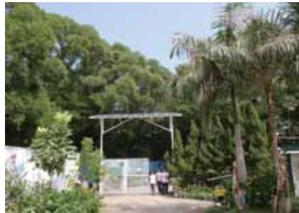
洗手間太陽能發電照明系統
